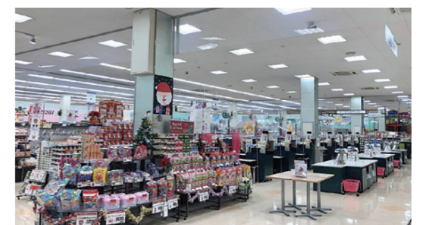
LED照明の設置
